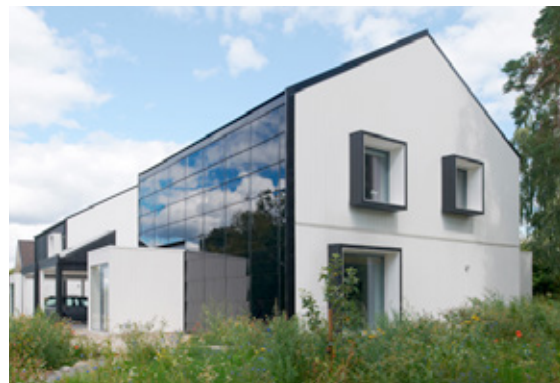
Ett exempel på byggnad där solcellsmoduler utgör både tak och fasad. (Ref: Hässelby. Foto: A-hus)
