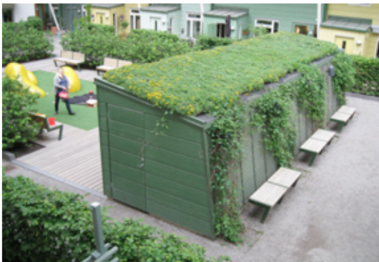
Gröna tak tar upp och fördröjer dagvatten samt skapar ett visuellt värde. (Foto: Vegtech AB).
