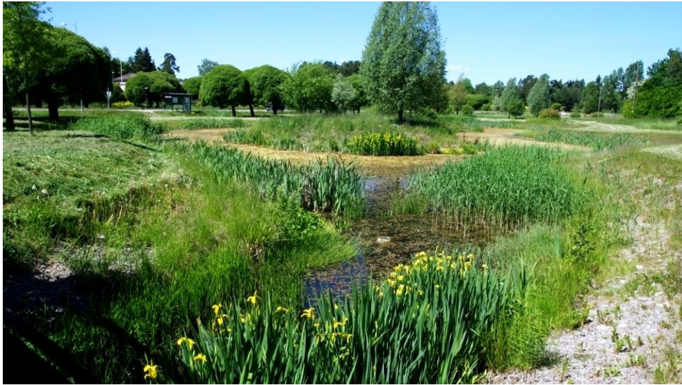
Visingedammen i Täby kommun är ett exempel på en ganska stor dagvattenanläggning som kombinerats med växtlighet. Många av principerna som tillämpas här går även att använda sig av vid anläggandet av mindre dammar eller diken. Foto: Barbro Beck-Friis.
