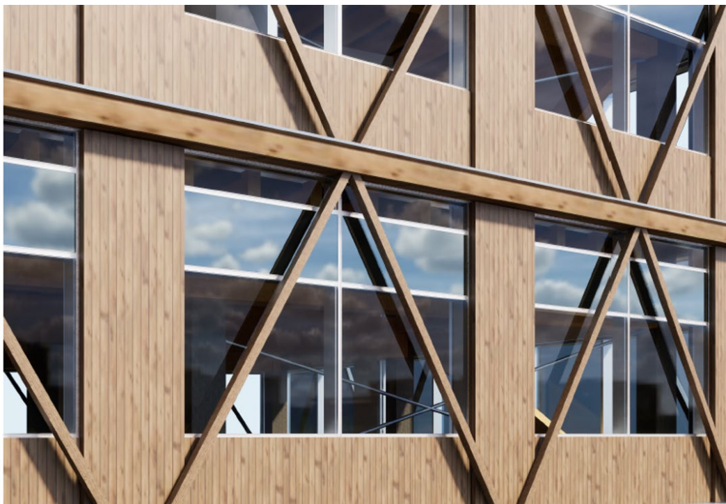
DE DIAGONALA STAGEN PÅ FASADEN.
